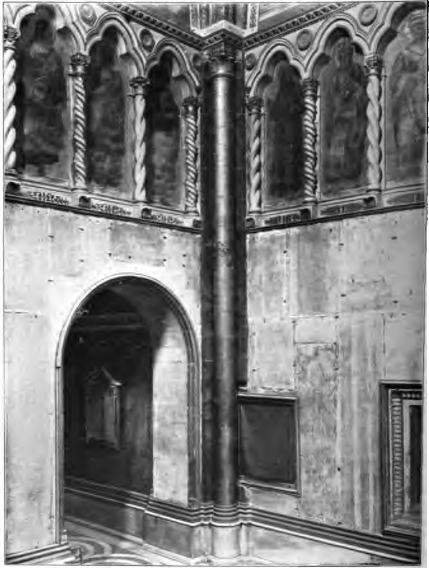
Bild 11. Südwestecke des Innern. Hallengang beim Eintritt.
